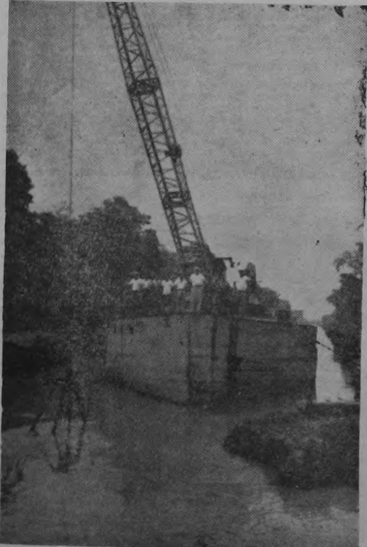
UNA DRAGA TERMINA LA UNION DE LAGUNAS, según se aprecia en la gráfica. Con esta parte de las obras de canalización de las Lagunas del Atlántico, se concluía una importante etapa de este proyecto, como era la habilitación de varios kilómetros más de canales navegables.
