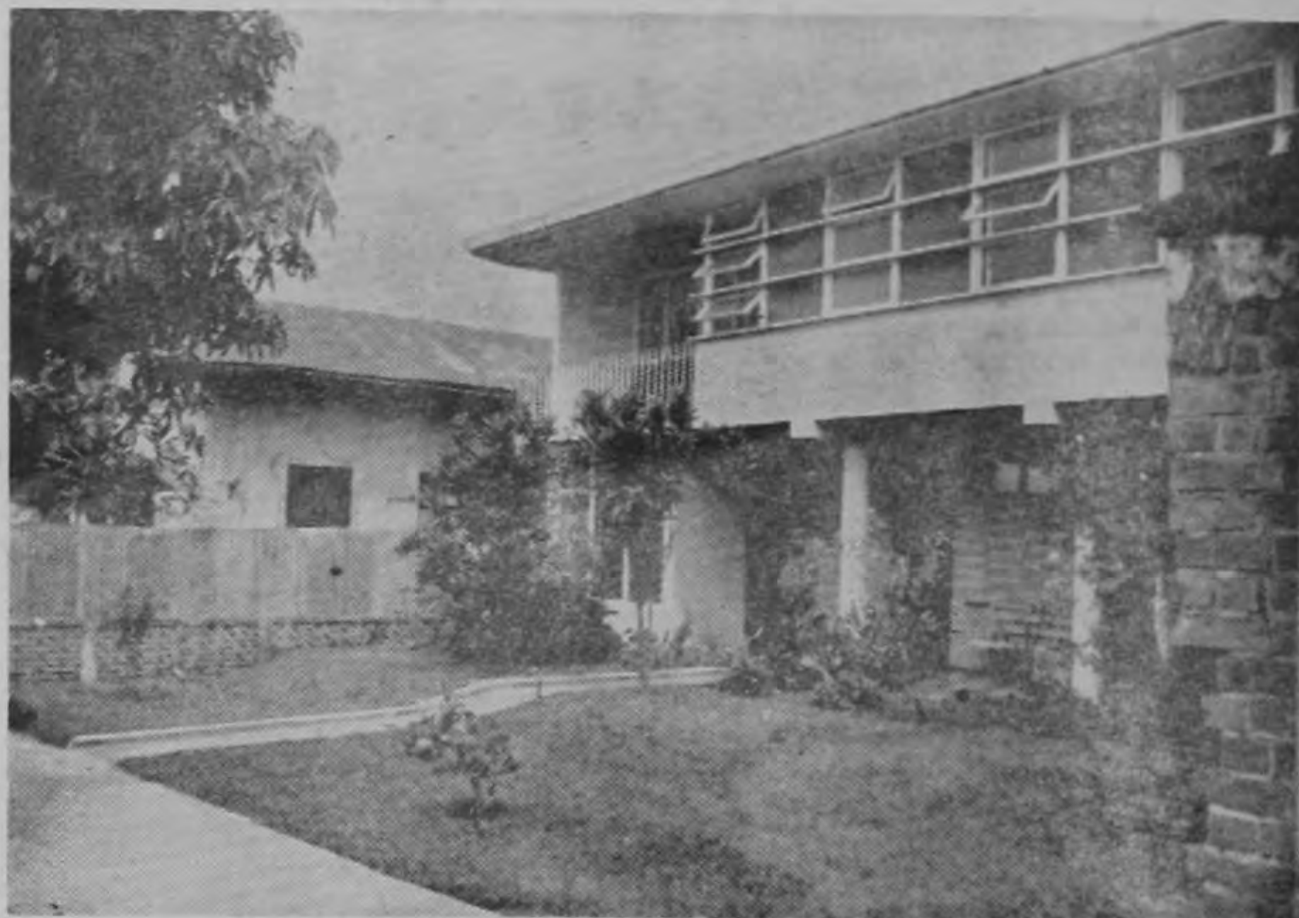
LA CASA CURAL. La Casa Cural de San Antonio de Belén, de moderna arquitectura, fue edificada por contribución popular. A la izquierda se ve el viejo edificio de la Escuela, que está siendo demolido. Allí se levantará el nuevo Edificio Municipal, Jefatura Política, Agencia de Extensión Agrícola y otros servicios comunales.
